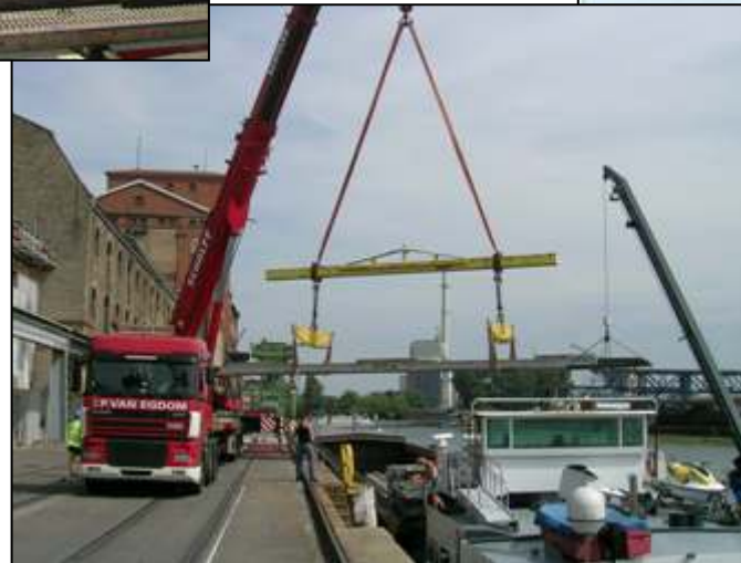
Transport der Gleistragplatten auf dem Wasserweg
