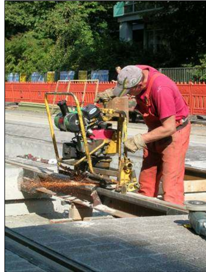
Verschweißen der Schienen
