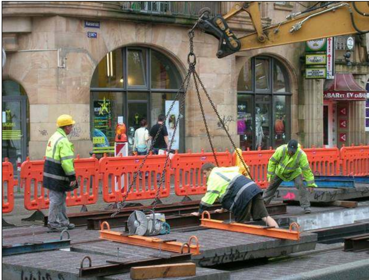
Einbau Mittelplatten mit Traversen
