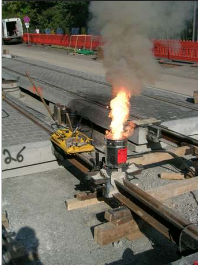
Verschweißen der Schienen
