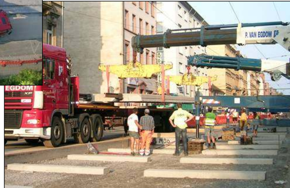
Einheben der Gleistragplatten
